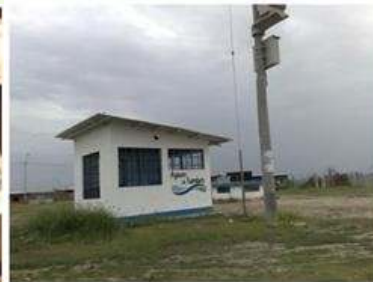
ESTACION DE BOMBEO DE AGUAS RESIDUALES
