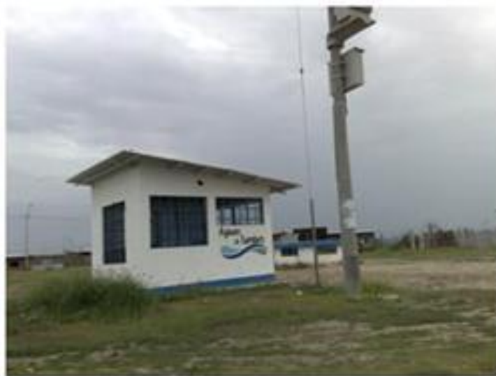
ESTACION DE BOMBEO DE AGUAS RESIDUALES
